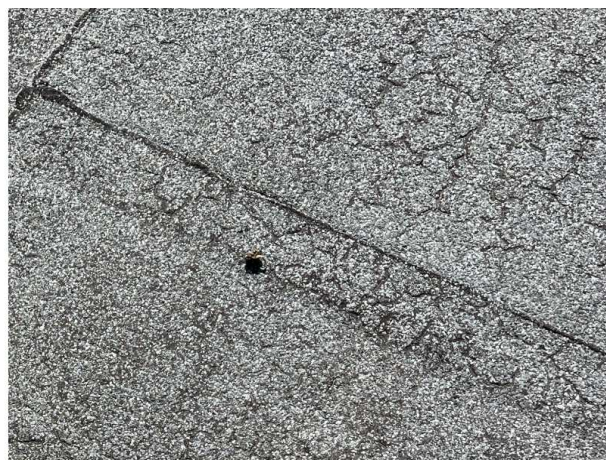
prokreslené spáry EPS, mikrotrhliny v povrchu asfaltu
